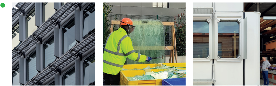
UNESCO Paris, France Patriarche Projet pilote de recyclage de vitrages architecturaux. Les fenêtres ont été démontées puis brisées pour obtenir du verre recyclable (calcin) à son tour recyclé pour créer du verre de haute qualité
